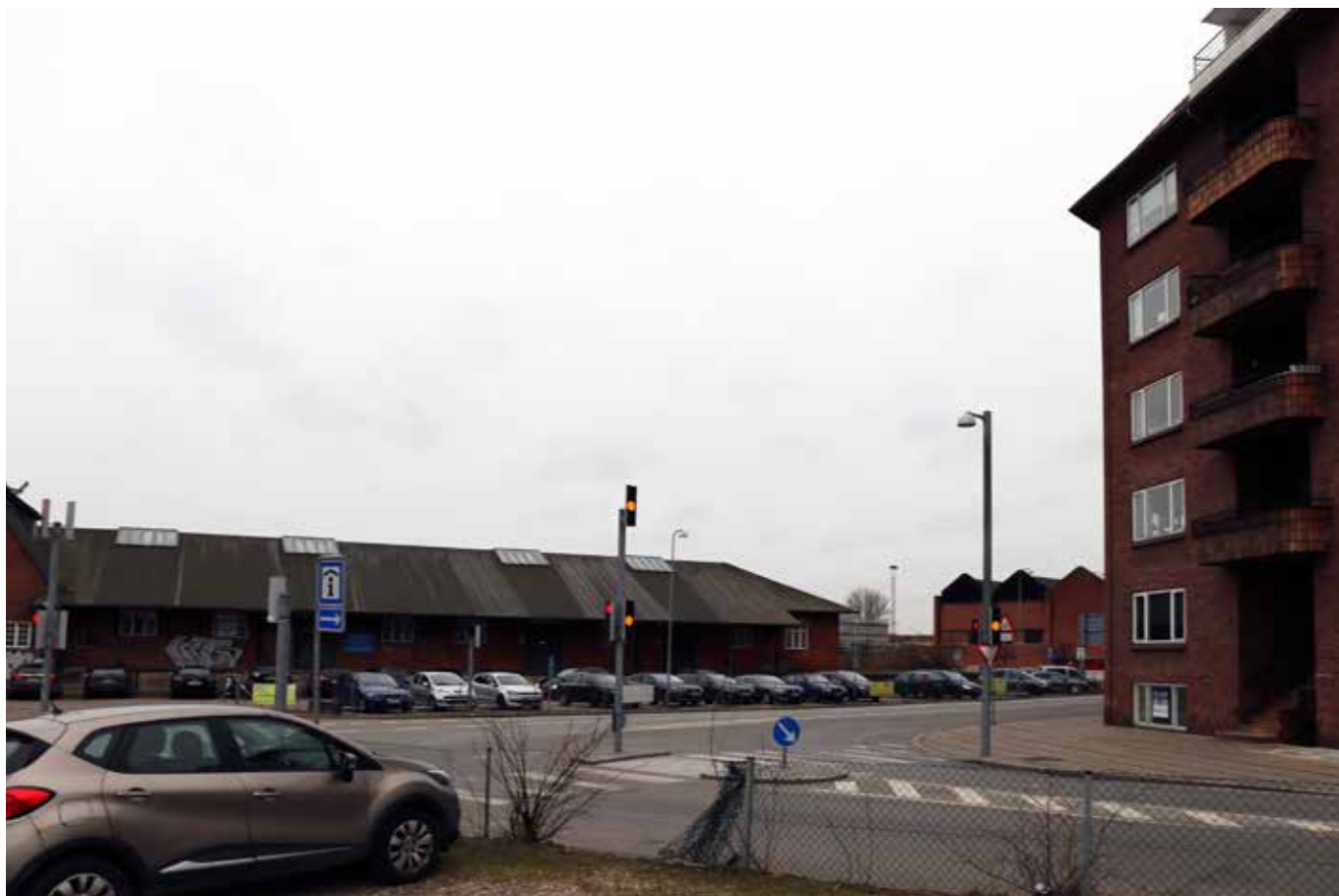
Standpunkt 2 set fra p-plads ved Borgvold, eksisterende forhold
